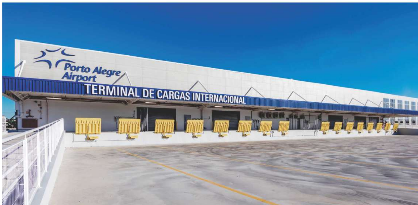
Novo Terminal de Cargas Internacional (TECA) do Porto Alegre Airport executado pela A.Yoshii.
