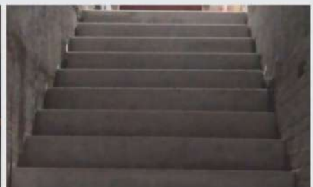
Placas pré-moldadas diminuem o tempo de execução da escada e garante excelente acabamento à escada de concreto.
